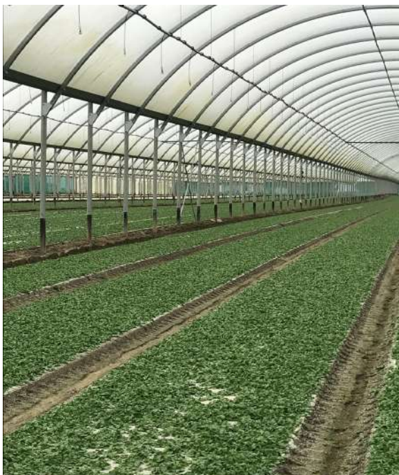
La serre existante sur le site de la Tourelle
