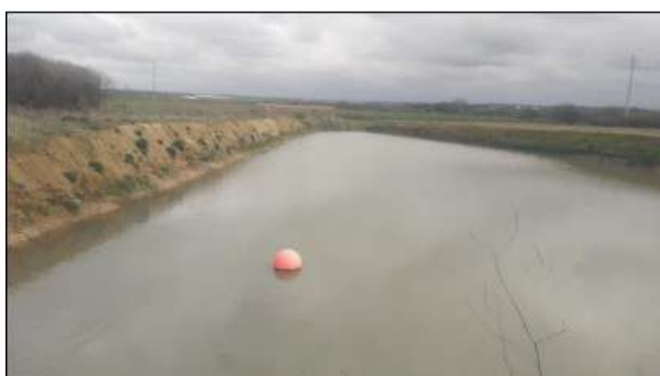
Bassin à aménager
